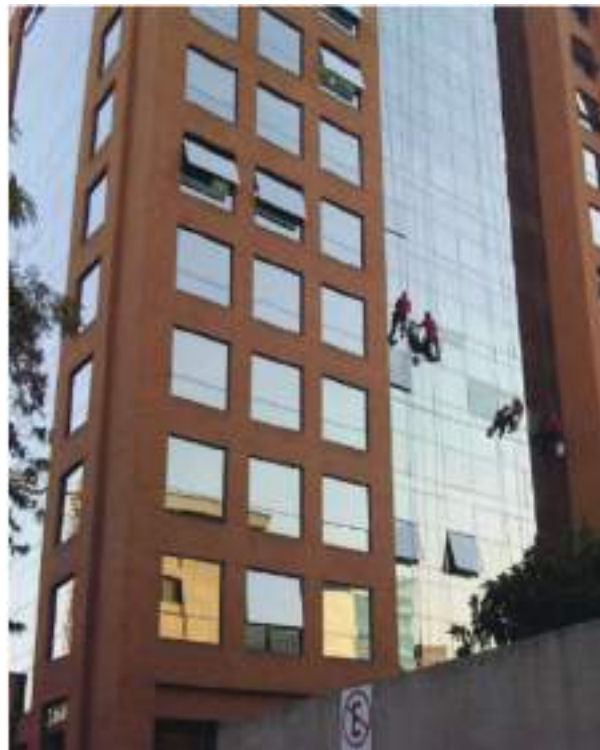
Figura 14.2. fachada vidriada lisa.
