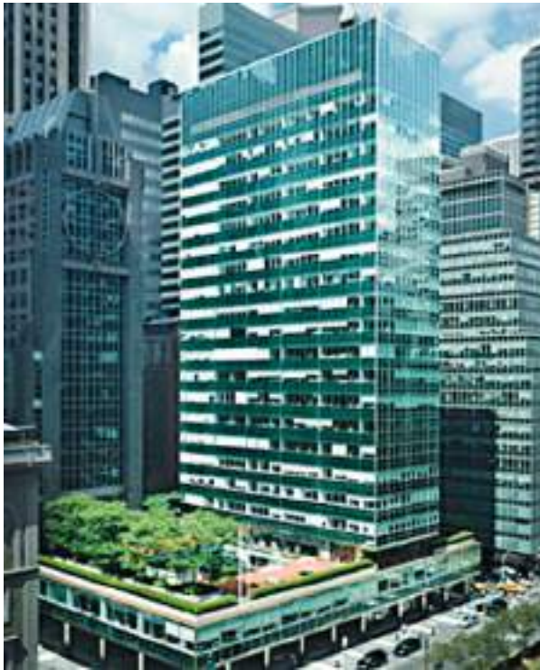
Figura 1.2. Vista panorámica de edificio con muro cortina.
