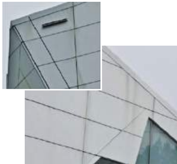
Figura 14.4. paneles ACM con junta abierta.
