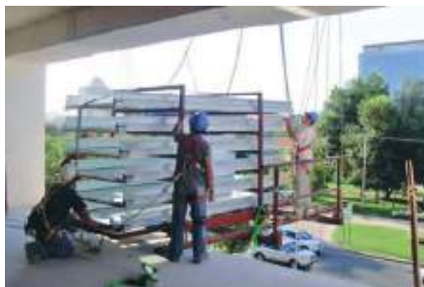
Figura 10.7. Traslado a piso de atril con muro cortina tipo frame.
