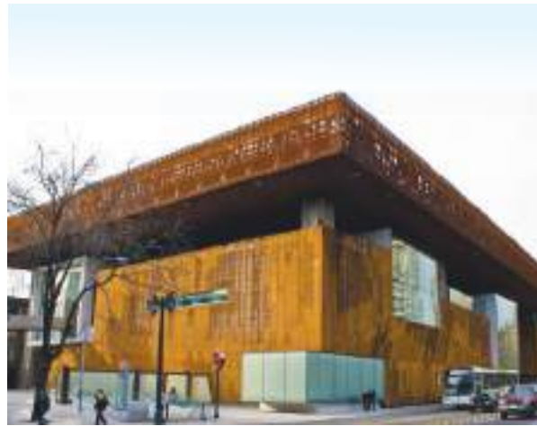
Figura 9.14. Vista exterior de la fachada ventilada del edificio GAM, Santiago.
