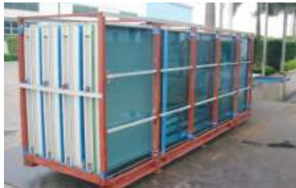
Figura 10.6. Atriles de transporte de taller a obra de paneles de muro cortina.
