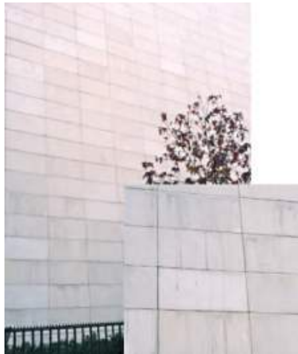
Figura 14.5. Fachada de piedras con junta abierta.
