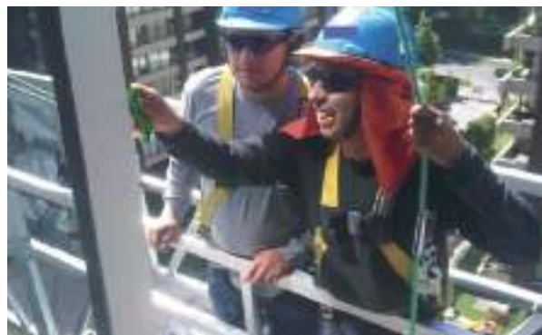
Figura 10.9. Personal de instalación en plataforma exterior.
